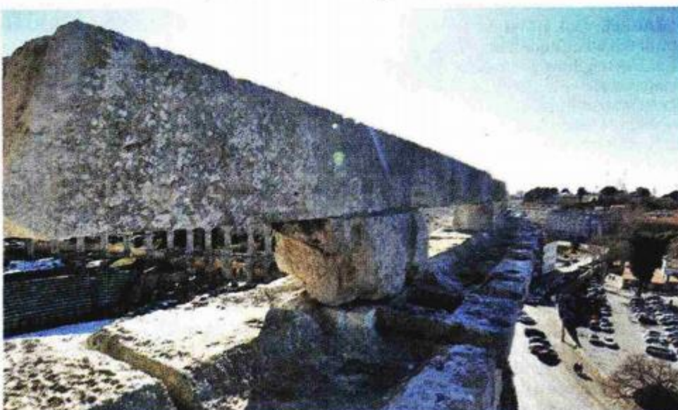
Završena je sanacija kule, a slijedeći je možda plašt
