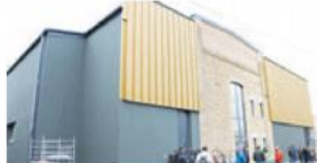
Kompleks skladišta i radionica HNK, Adžijina 7a
