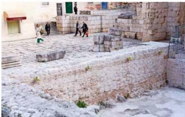
Srušen je betonski zid sa sjeverne strane katedrale Sv. Dujma
