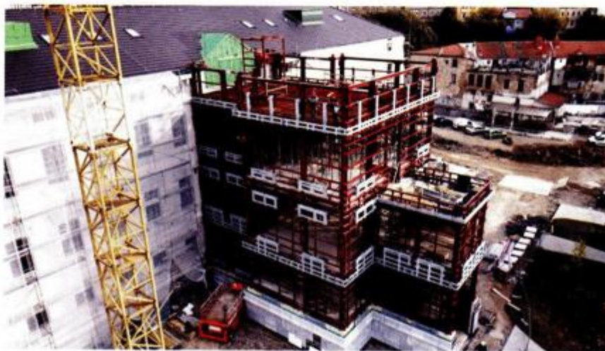
Montaža čelične konstrukcije nožice
