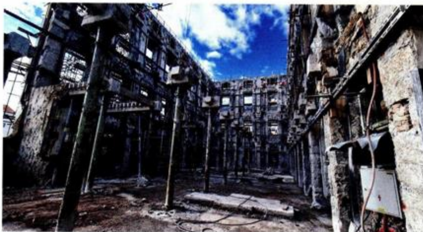
Uklanjanje postojeće konstrukcije unutar vanjskih kamenih zidova
