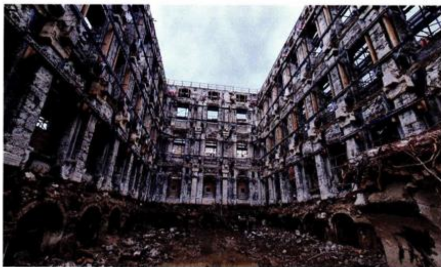
Uklonjena kompletna konstrukcija unutar vanjskih kamenih zidova
