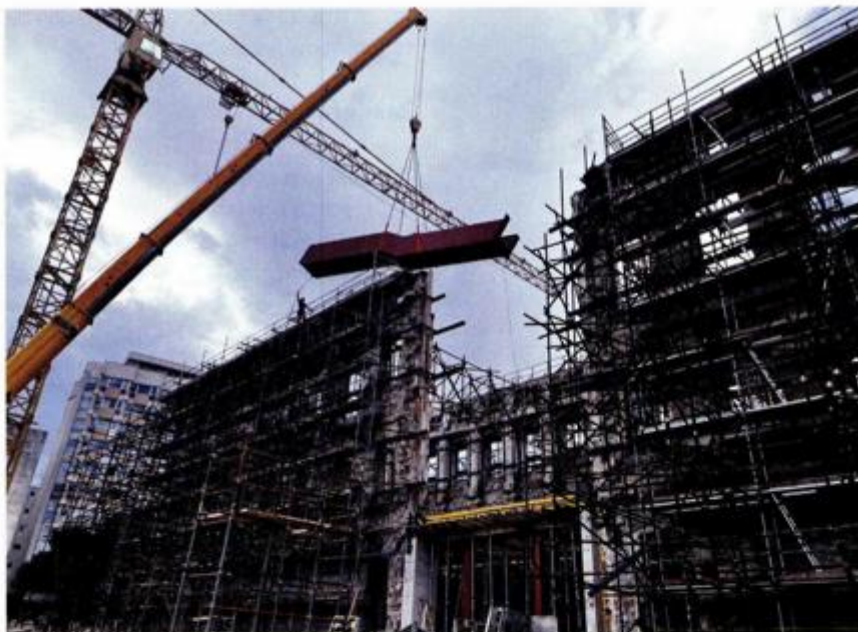
Montaža čeličnog stubišta
