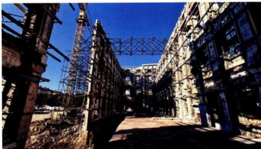
Postojeći kameni zidovi pridržani skelom; uklanjanje konstrukcije suterena
