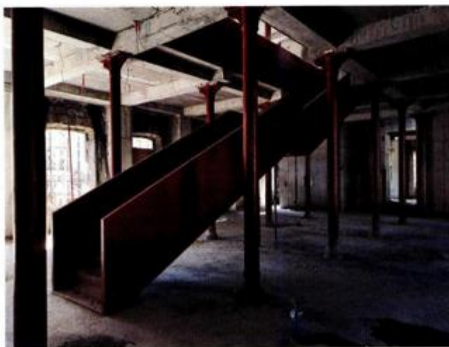
Čelično stubište u prizemlju sjevernog dijela
