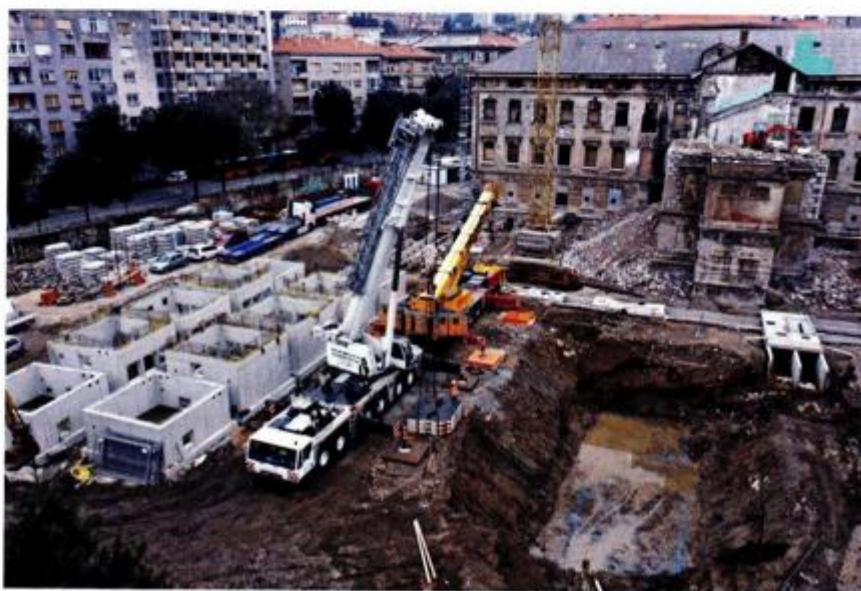
Polaganje retencija i crpnih stanica; rušenja nožice T-objekta u pozadini
