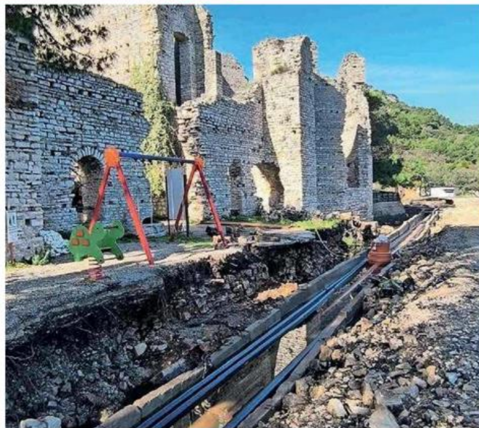
Novi sustav odvodnje opasao je antičku palaču u Polačama
