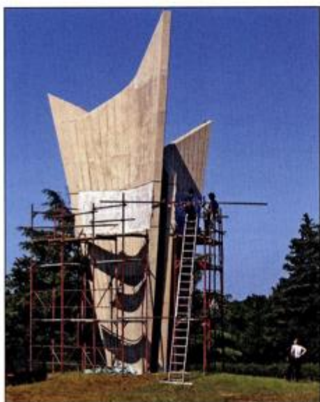
Radovi na obnovi mozaika
