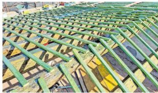
Stavljaju se nove dašćane letve s premazom na kojima se slažu nove tavelice
