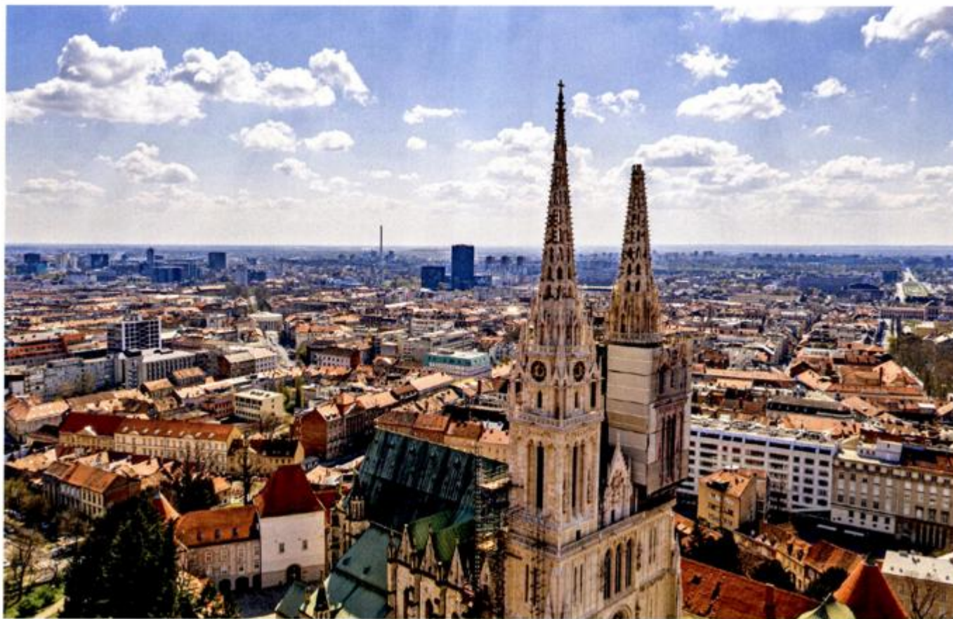
Katedrala nakon oštećenja u potresu 22. ožujka 2020., foto: Paolo Mofardin
