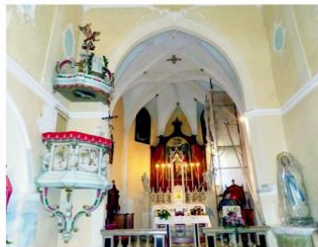
Sv. Bartol Roč: konzervatorsko - restauratorski radovi
