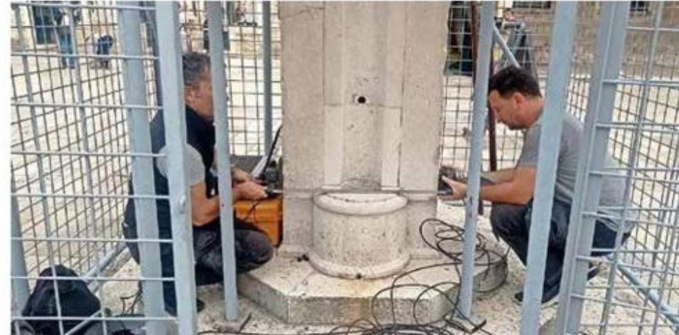
**Očekuju se još rezultati nedavno obavljenog ultrazvučnog mjerjenja pukotina, koji će dati podatke o njihovoj međusobnoj povezanosti i dubini**
