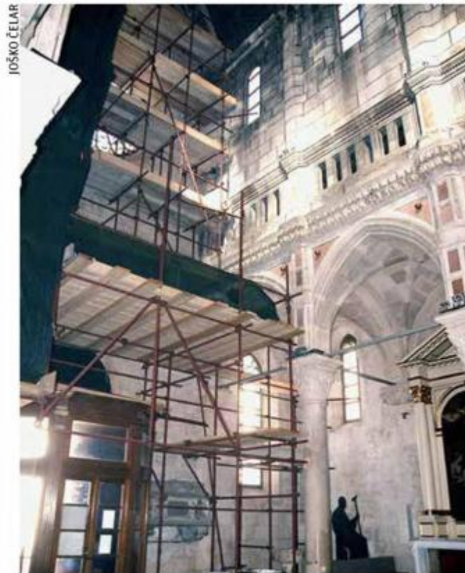
Skele su već postavljene s unutarnje strane glavnog portala
