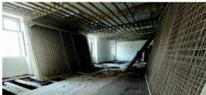
Sanacija međukatne konstrukcije
