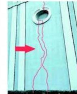
Oštećenja su uočena na brodu i koru kao značajna napuknuća zida i svoda, najčešće na mjestima otvora
