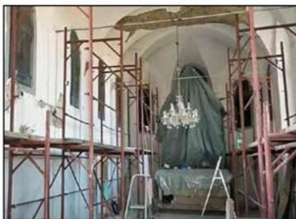
Crkva je oštećena i unutra
