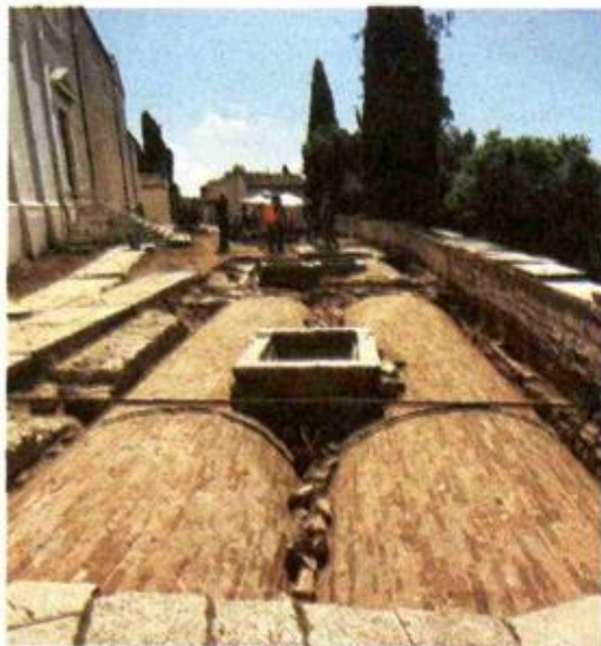
Svodovi podzemne crkve sv. Mihovila
