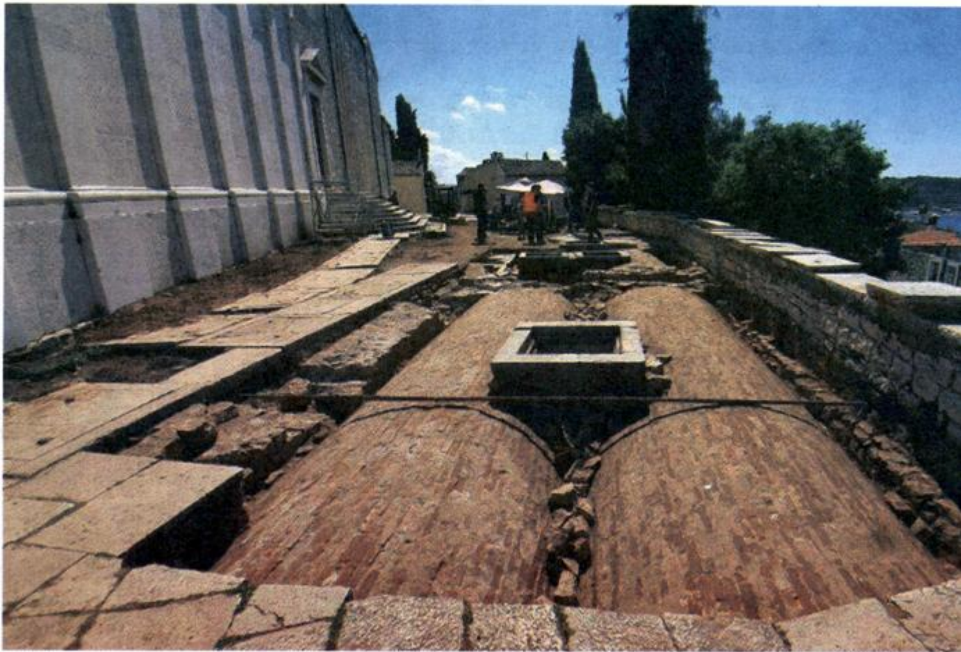
Svodovi podzemne crkve
