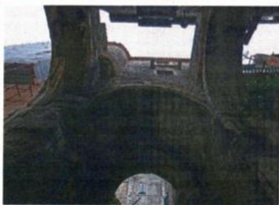
Drevni graditelji znali su što je serklaž
