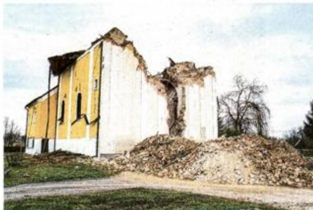
Uništena crkva u Žažini
