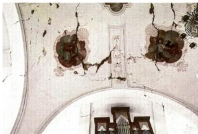
Oštećeni svod crkve u Pokupskom
