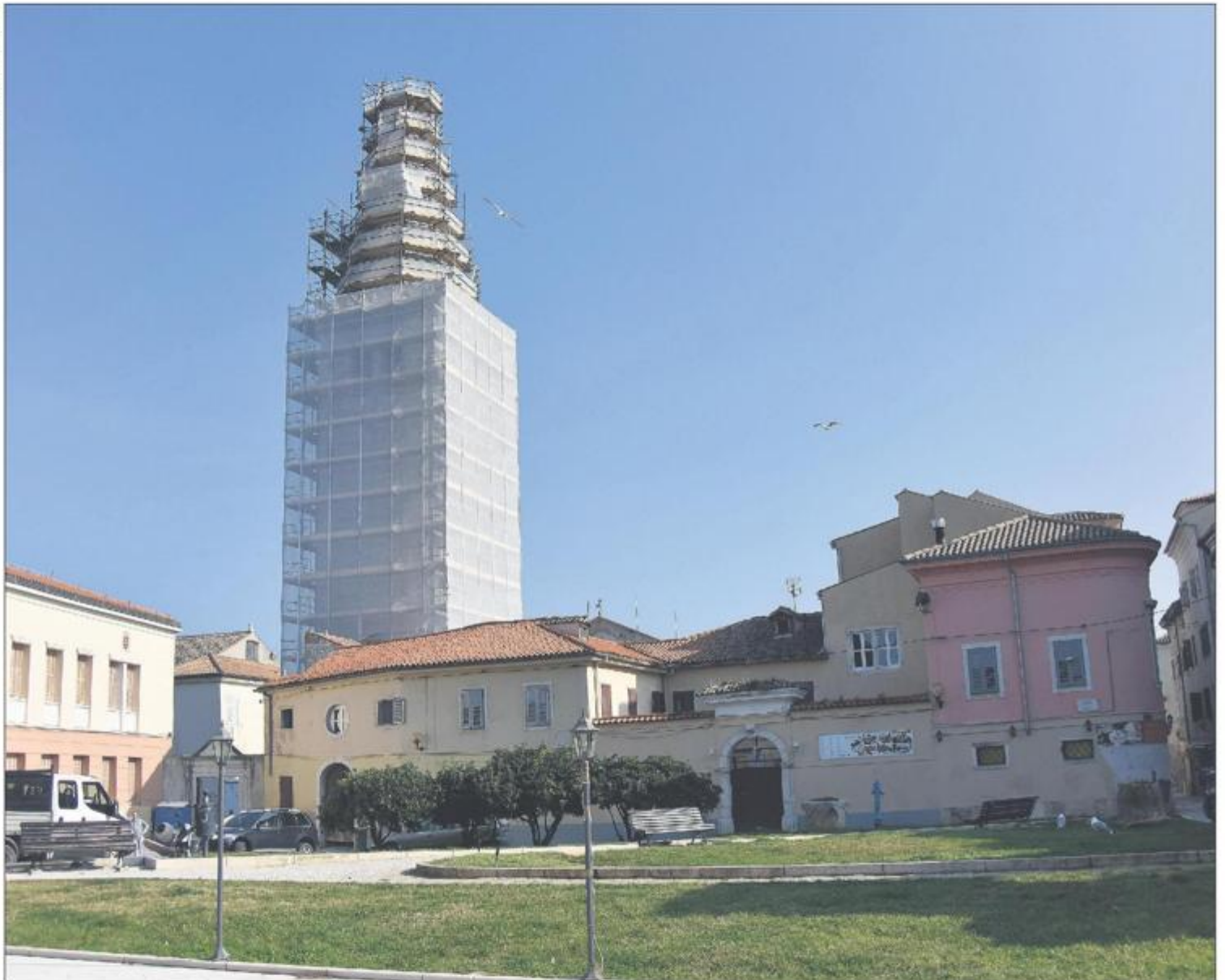
OBNOVA OD 2018. GODINE Obnova zvonika počela je dopunom dokumentacije postojećeg stanja, preliminarnom analizom stanja konstrukcije te provedbom sondiranja i iscrpnih laboratorijskih analiza zatečenih žbukanih slojeva na dostupnim dijelovima pročelja zvonika. Nakon dovršetka ovih aktivnosti i usvojenih tehničkih rješenja, radovi su počeli potkraj 2019. godine
