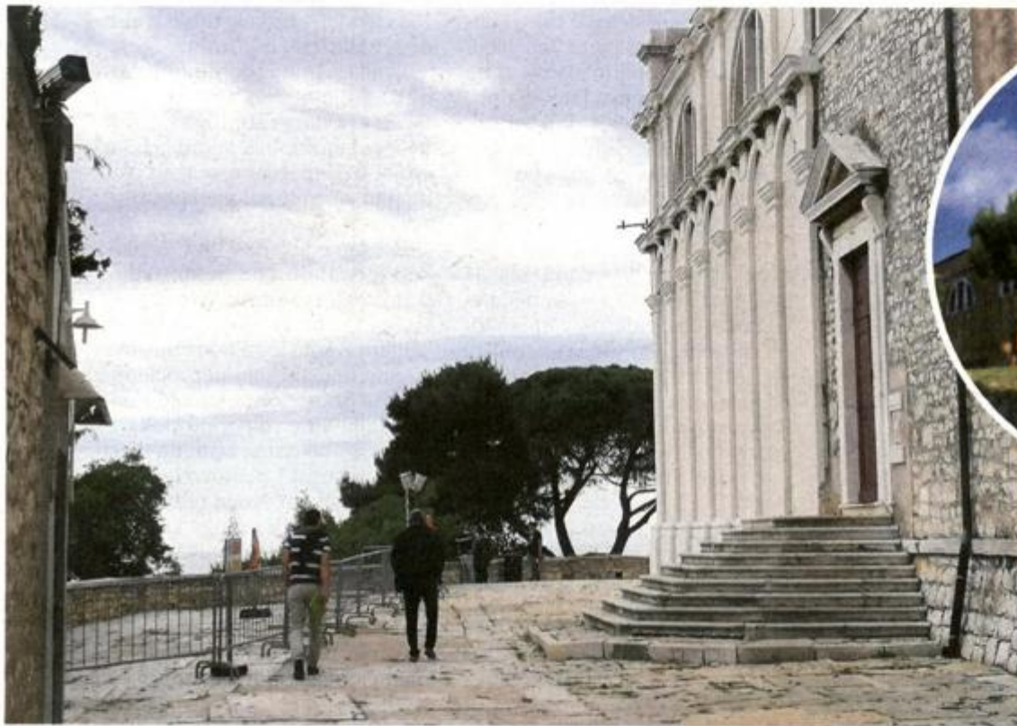
Ograda označava gdje će se odvijati radovi na južnoj strani dvorišta
