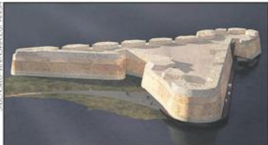
Projektom je dano rješenje sanacije dotrajalih i oštećenih građevnih struktura tvrđave
