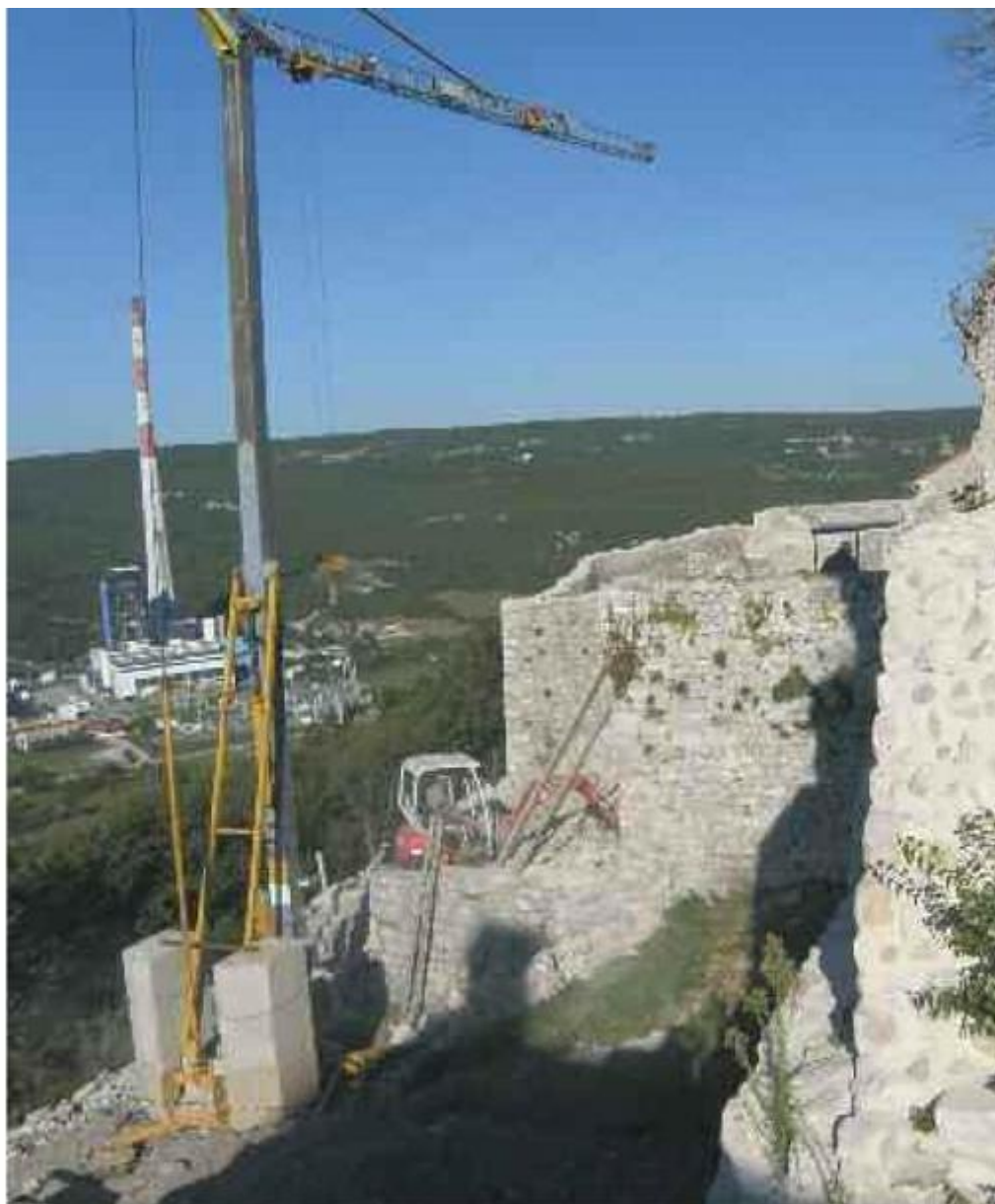
Radovi na južnim plominskim zidinama
