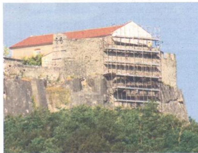
Sanacija gradskih bedema i sjevernog zida crkve
