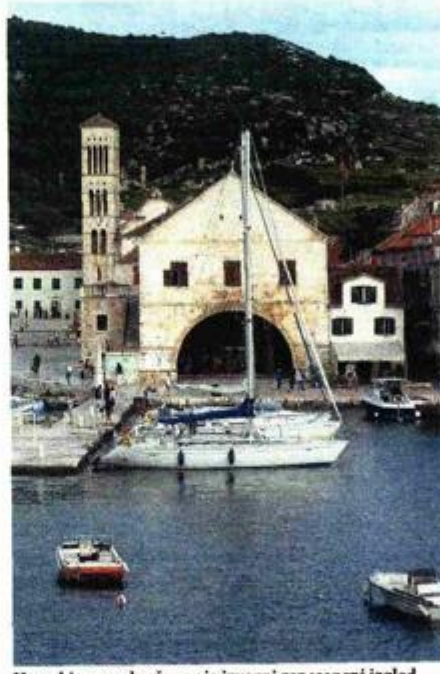
Hvarski arsenal sačuvali je izvorni renesansni izgled
