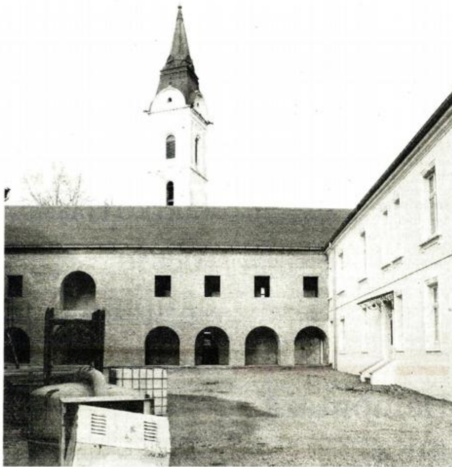
Jedno krilo Vladučanskog dvora u potpunosti je obnovljeno, a ostala dva još su u radu
