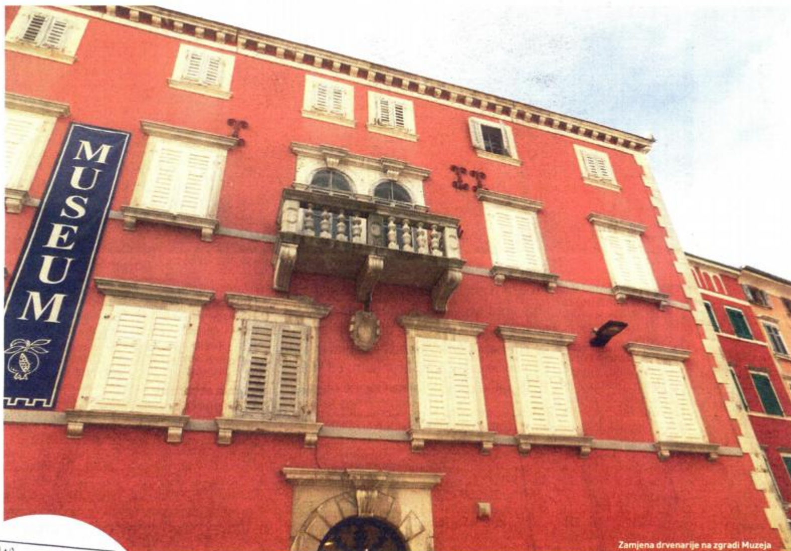
Zamjena drvenarije na zgradi Muzeja
