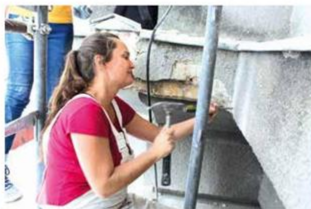
Restauratorica Nena Brkić (Teh-gradnja) provodi detaljna restauratorska istraživanja glavnoga pročelja 2017.
