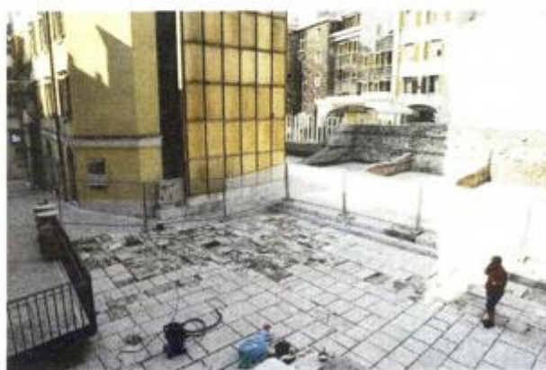
Zbog radova dio lokacije je ograden metalnom ogradom
