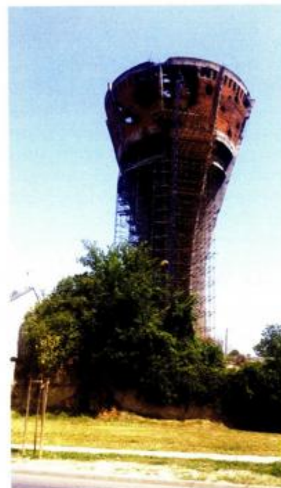
Vodotoranj pod skelama
