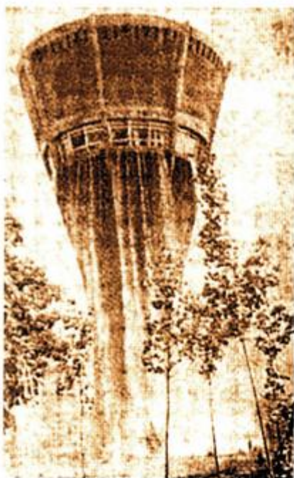
Vodotoranj je imao veliku havariju dvije godine nakon otvaranja kada mu se čelični rezervoar "zgužvao" i sva voda iscurila (zahvaljujući ing. B. Božiću)
