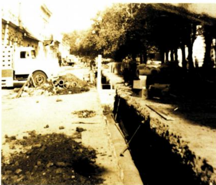
Detalj gradnje vodoopskrbne mreže (zahvaljujući kolekcionaru Branku Moritzu)
