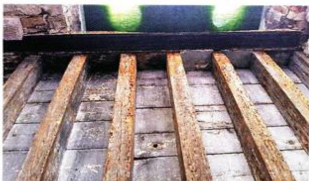
Na drvenim pločama između greda vidjeli su se tragovi boje...
