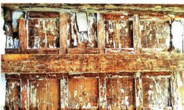
Na gotičkom kasetiranom stropu malo je toga ostalo sačuvano
