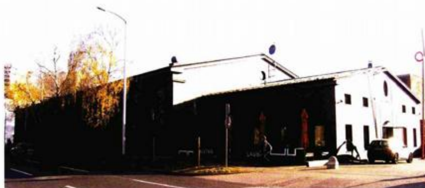
Pogled sa sjeverozapada na negdašnju jahaonicu, a današnju Laubu – kuću za ljude i umjetnost
