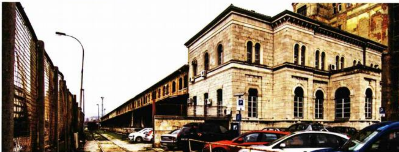
Skladište IIIb s pročelnom zgradom
