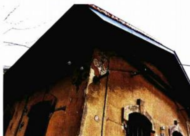
Detalj glavnog pročelja zgrade
