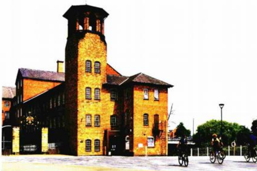
Zgrada bivše tvornice svile u Derbyju koja je prenamijenjena u muzej
