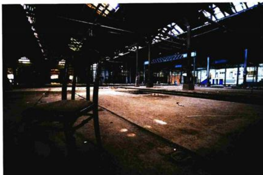
Napuštene hala bivše tvornici Gredelj u Zagrebu
