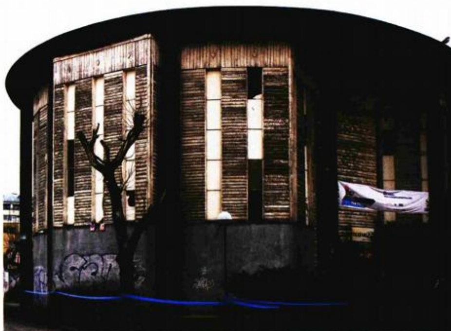
Francuski paviljon, stanje prije obnove 2007.
