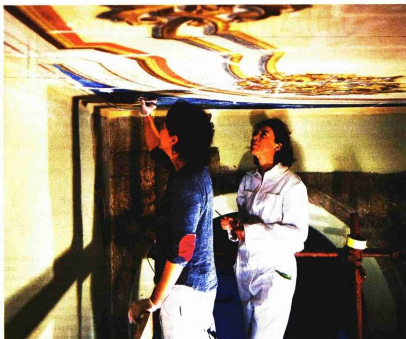
Atrij šibenskog kazališta do kraja godine dobit će novi izgled. Riječ je o restauratorsko konzervatorskim radovima na stropu i sjevernom zidu istočnog atrija, nakon kojih će strop biti saniran, a na cijelom zidu bit će vraćena izvorna oslika koju je do sada prekrivala žbuka.
