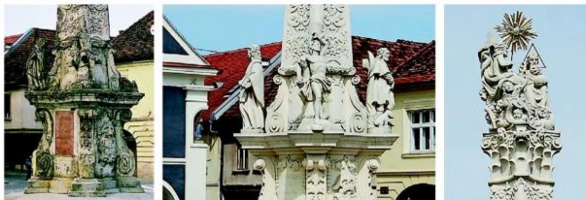
Kužni pil u Požegi - detalji izgleda prije i nakon radova obnove
