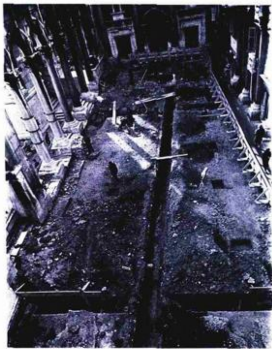
▲ Spuštanje podnice Peristila na pretpostavljenu izvornu razinu, 1959.-1961.
