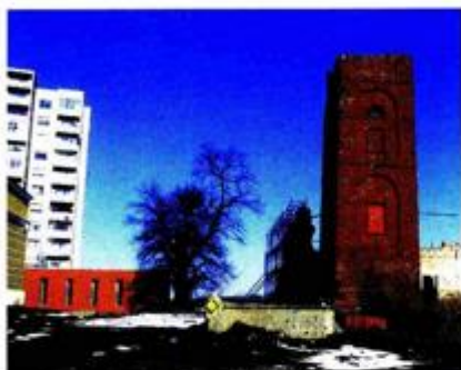
Vodotoranj i negdašnja smjemenarna uoči obnove
