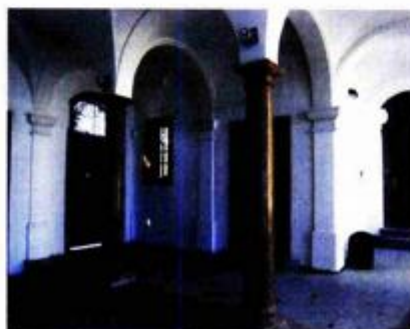
Obnovljeno predvorje dvorca
