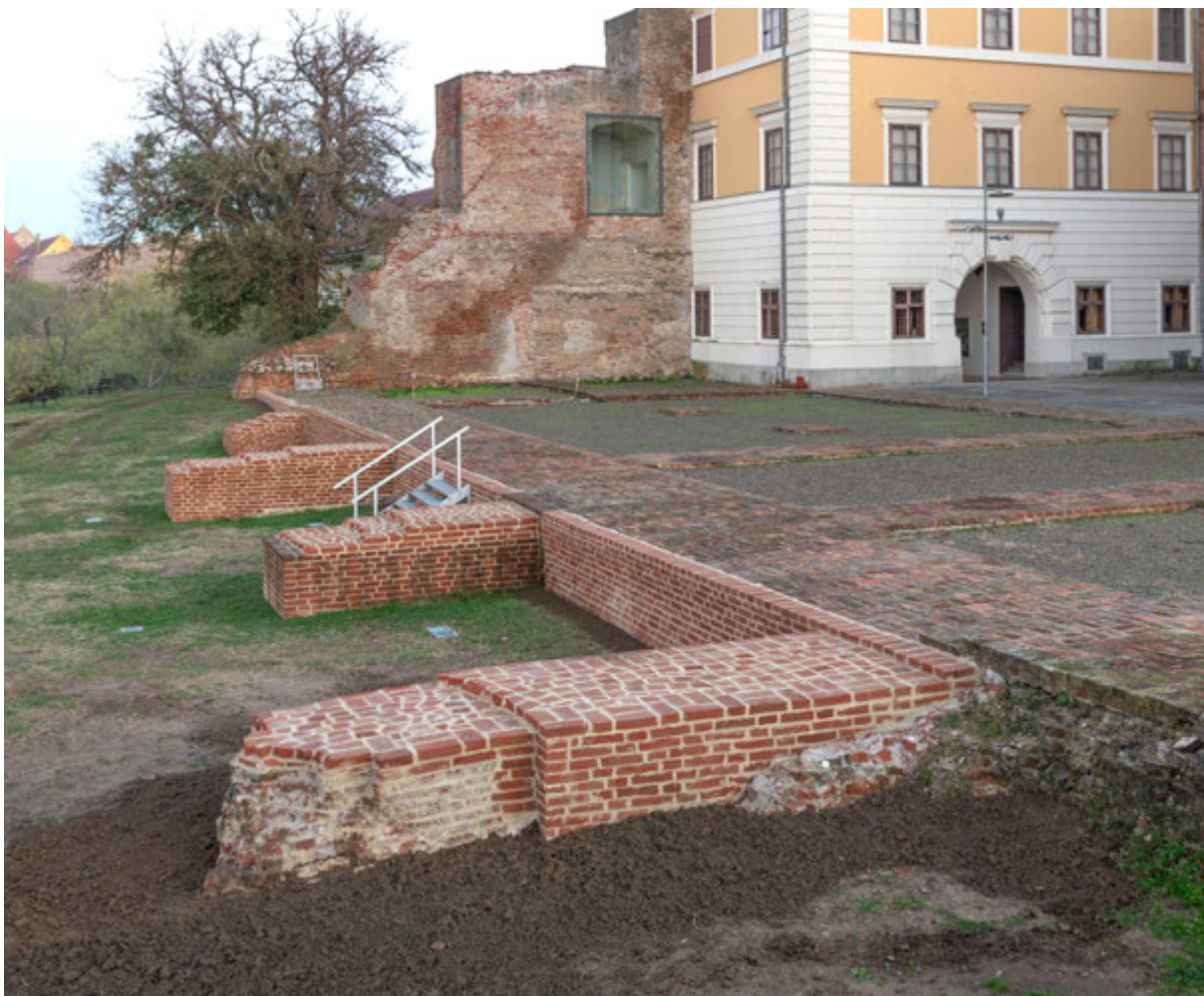
Ilok, dvorac Odescalchi, stanje nakon radova sanacije kontrafora. Snimka: G. Tomljenović, 2023.
