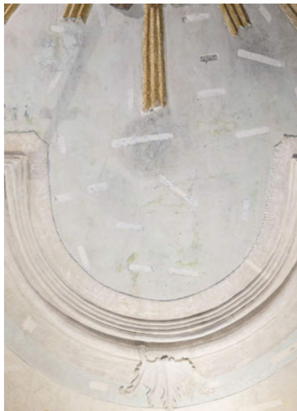
Roč, župna crkva sv. Bartola. Detalj središnjega medaljona i stropa nakon uklanjanja naknadnih naliča i neadekvatnih rekonstrukcija. Snimka: Lj. Gamulin, 2023.
