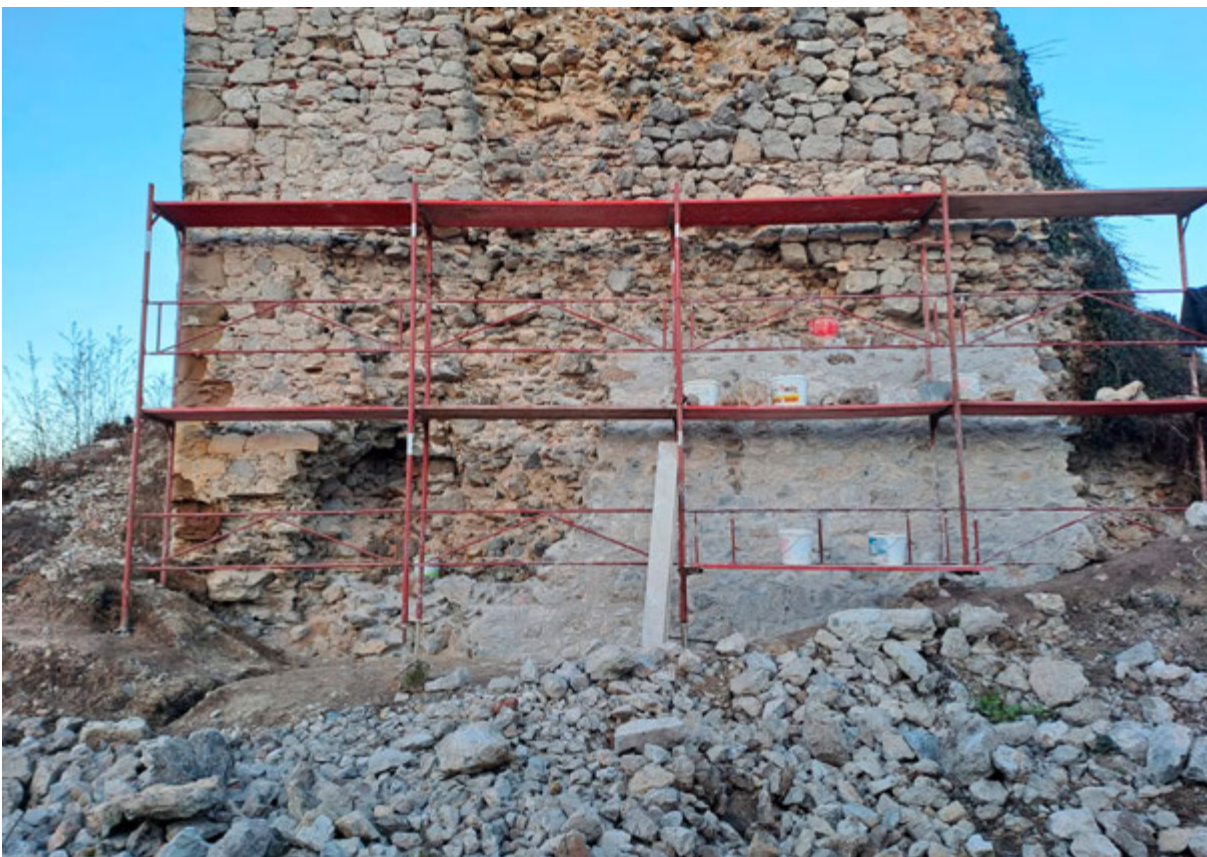
Pregrada, Stari grad Kostelgrad, stanje tijekom radova. Snimka: I. Marinković, 2023.
