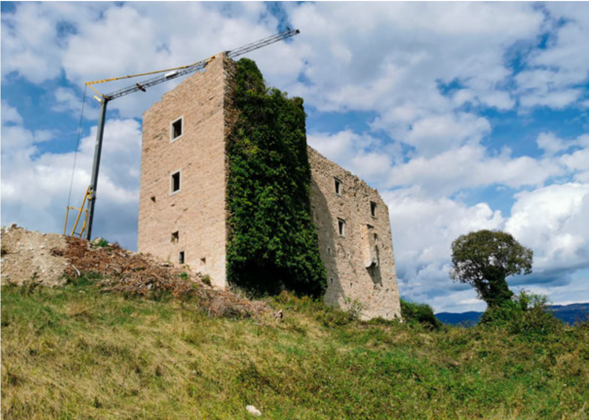
Paz, kaštel Paz. Vanjsko lice zapadnog zida kule nakon radova. Snimka: J. Višnjic, 2023.
