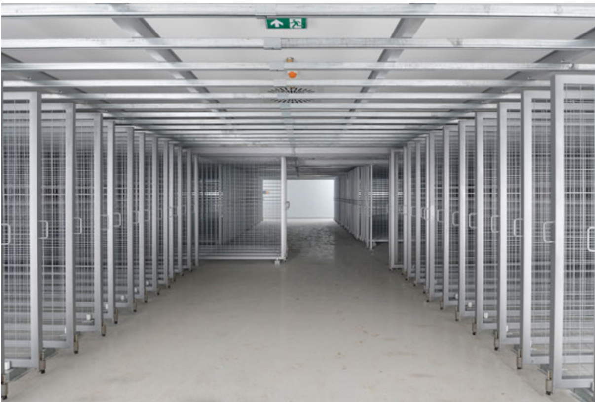
Jastrebarsko, bivša Vojarna „Dr. Ante Starčević“ (zgrade 2, 3, 4, 5, 6, 7 i 63). Zgrada 5, unutrašnjost, nakon izvedenih radova. Snimka: G. Tomljenović, 2023.
