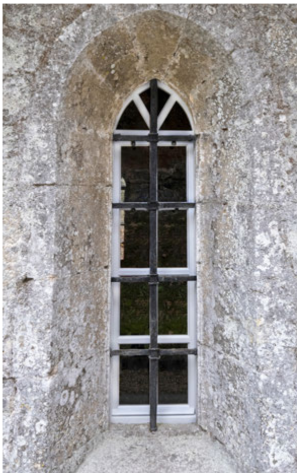
Beram, kapela sv. Marije na Škrilinah, nova stolarija prozora sjevernog zida lađe, pogled izvana i iznutra. Snimka: Lj. Gamulin, 2023.
