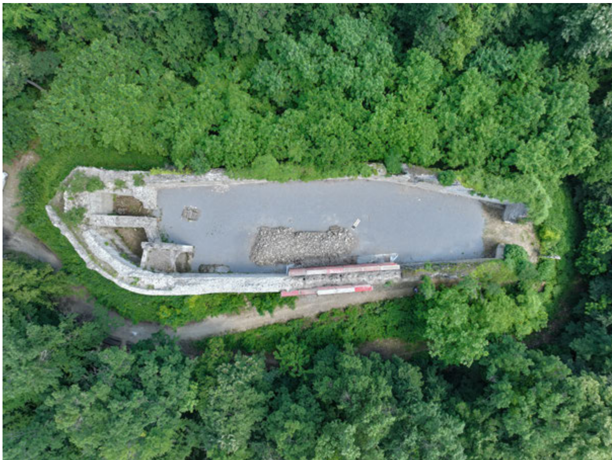
Popovača, Stari grad Jelengrad, pogled na grad iz zraka. Izrada: Skimi d.o.o., 2022.
