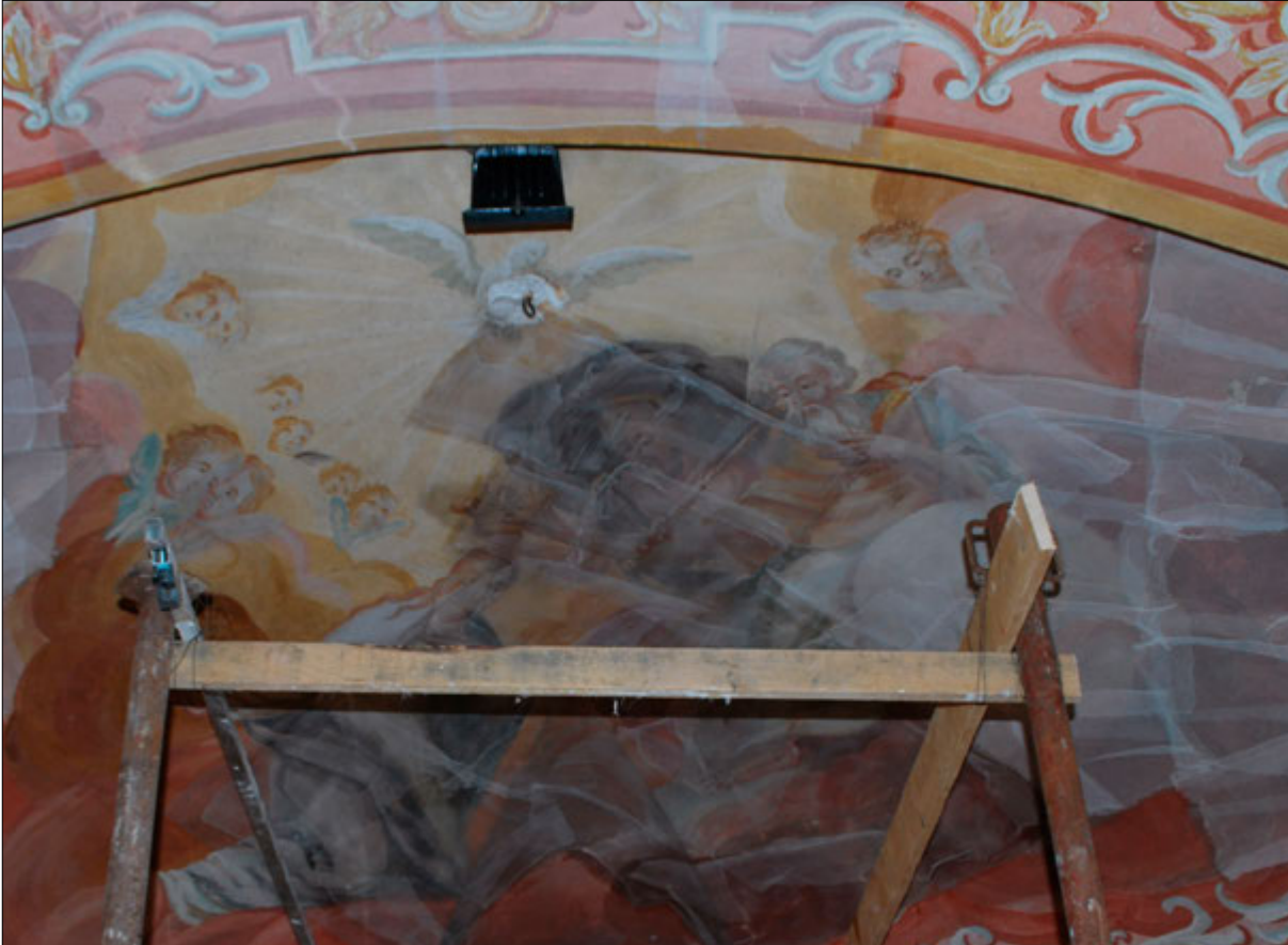
Križevci, crkva Majke Božje Koruške, konha sjeverne apsida svetišta, privremena zaštita oslika prije statičke sanacije, stanje nakon radova. Snimka: B. Braun, 2023.
