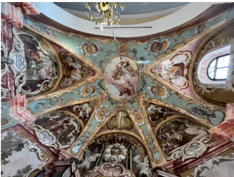
Koprivnički Ivanec, crkva sv. Ivana Krstitelja, pogled na svod svetišta nakon radova. Snimka: A. Filip, 2023.
