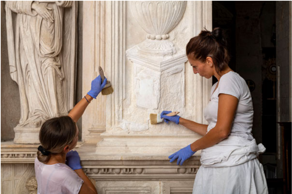
Trogir, katedrala sv. Lovre, kapela Orsini. Stanje tijekom radova – konsolidiranje. Snimka: P. Gamulin, 2023.
