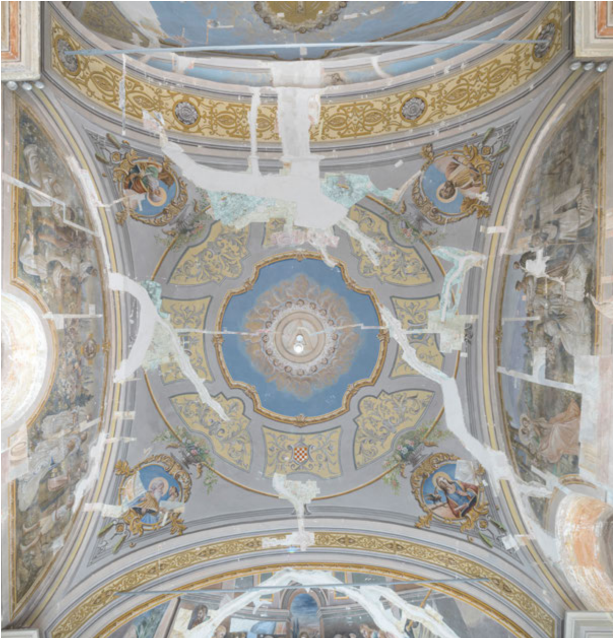
Jastrebarsko, crkva sv. Nikole biskupa, pogled iz lađe prema svetištu nakon građevinske sanacije. Snimka: K. Gavrilica, 2023.
