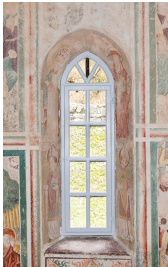
Beram, kapela sv. Marije na Škrilinah, nova stolarija prozora sjevernog zida lađe, pogled izvana i iznutra. Snimka: Lj. Gamulin, 2023.
