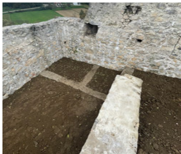
Barilović, Stari grad Barilović, pogled na jugozapadni zid nakon radova. Snimka: R. Ledinek, 2023.
