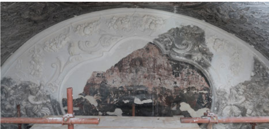
Lepoglava, bivši pavlinski samostan i župna crkva Bezgrešnog začeća Blažene Djevice Marije – bivša knjižnica. Zapadna luneta nakon završetka kiparske rekonstrukcije štukodekoracija. Snimka: K. Gavrilica, 2022.
