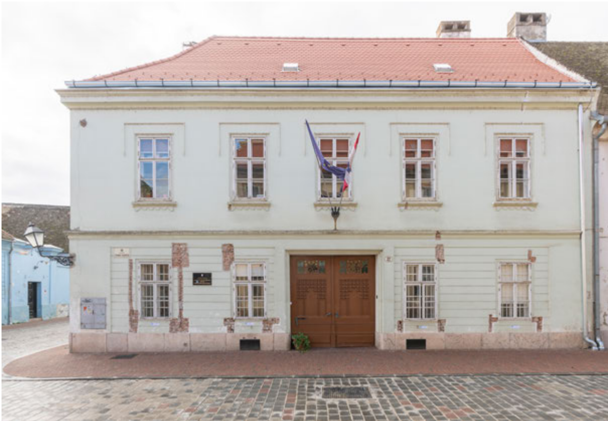
Osijek, Tvrđa, kuća Raith, Ulica Franje Kuhača 27. Sonde otvorene na glavnom pročelju. Snimka: I. Marinković, 2023.
