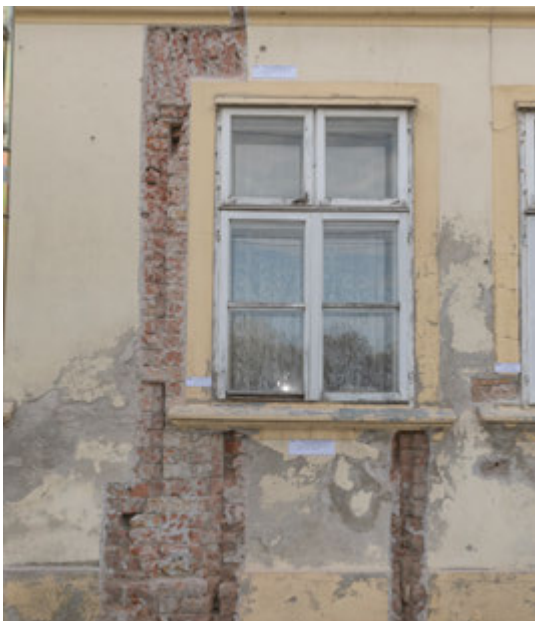
Osijek, Strossmayerova 33, stambena katnica. Sonda kojom je otkriven jedan od tri zazidana otvora na sjevernom, uličnom pročelju. Snimka: I. Marinković, 2023.
