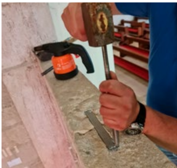
Hvar, franjevački samostan, crkva sv. Marije, kapela Sv. Križa tijekom radova. Snimka: I. Sikavica, 2024.
