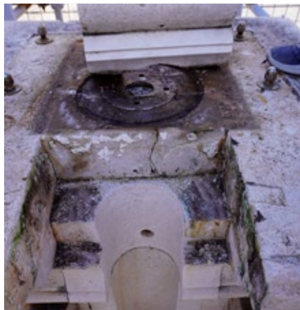
Dubrovnik, Orlandov stup, uklanjanje kamenih elemenata radi pristupa matici. Snimka: A. Gluhan, 2024.
