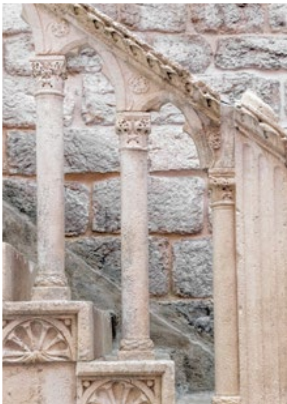
Šibenik, crkva sv. Ivana, južna fasada, stubište, balustrada nakon radova. Snimka: M. Pavin, 2024.
