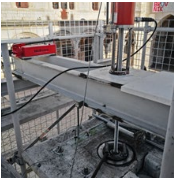
Dubrovnik, Orlandov stup, pokušaj strojnog otpuštanja sile centralnog trna. Snimka: A. Gluhan, 2024.
