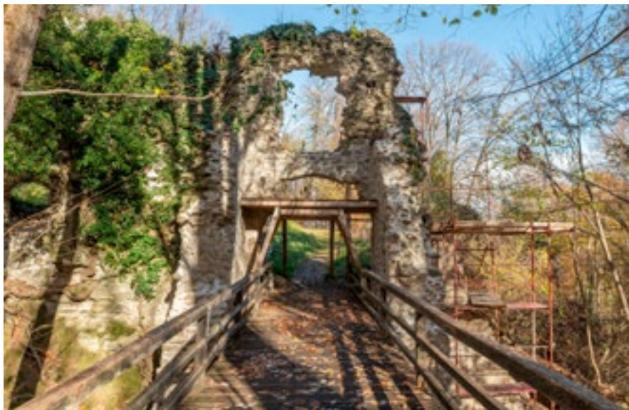
Podgarić, Stari grad Garić-grad, potporno-zaštitna skela i obrambeni zid kod ulaza u grad tijekom radova. Snimka: I. Marinković, 2024.
