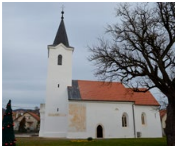
Martinšćina, kapela sv. Martina. Pogled na južno pročelje zvonika nakon radova 2024. Snimka: A. Čurić, 2024.
