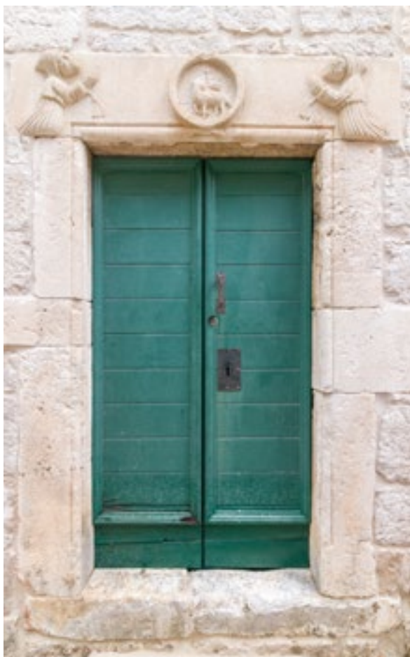
Šibenik, crkva sv. Ivana, južna fasada, stubište, portal nakon radova. Snimka: M. Pavin, 2024.
