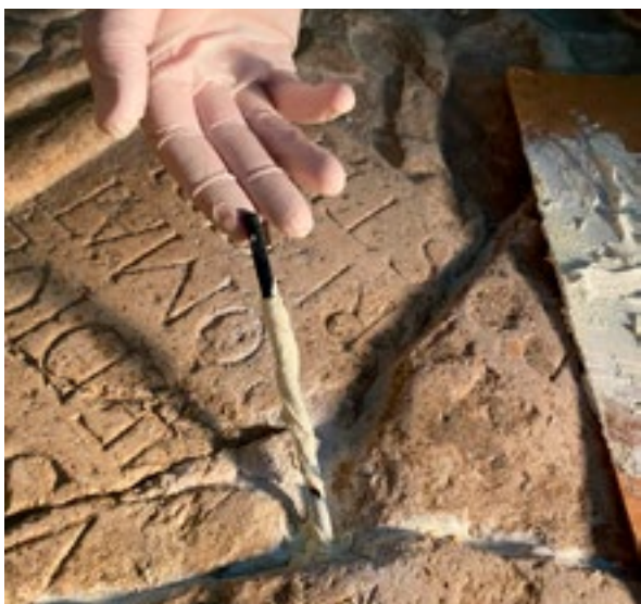
Hvar, franjevački samostan, crkva sv. Marije, kapela Sv. Križa, učvršćenje oštećene kamene grobne ploče. Snimka: I. Sikavica, 2024.
