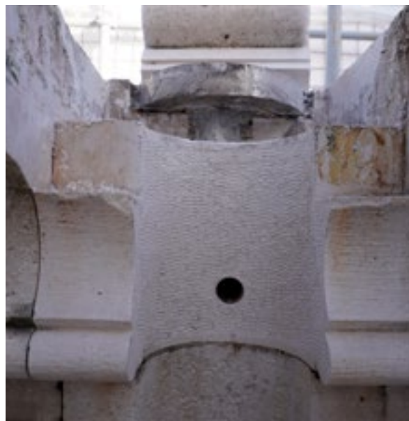
Dubrovnik, Orlandov stup, pogled na maticu nakon uklanjanja kamenih elemenata stražnje strane stupa. Snimka: A. Gluhan, 2024.
