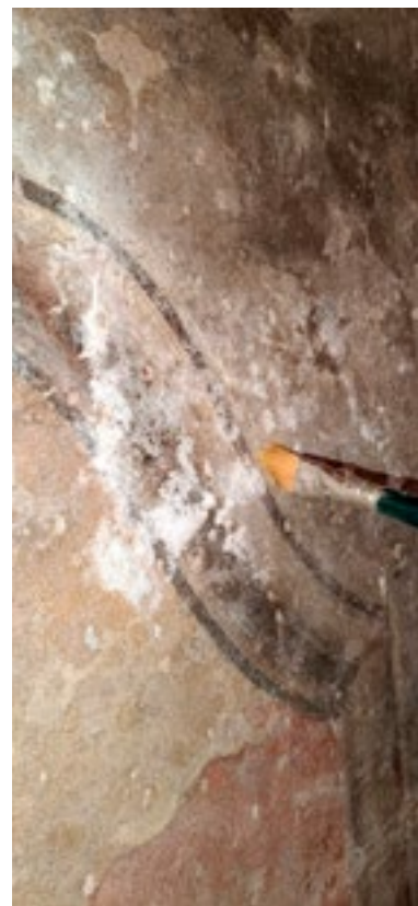
Zagreb, Remete, crkva Uznesenja Blažene Djevice Marije. Iščerkavanje vodotopivih soli s površine slikanog sloja na zapadnom zidu lađe. Snimka: M. Jelenčić, 2024.
