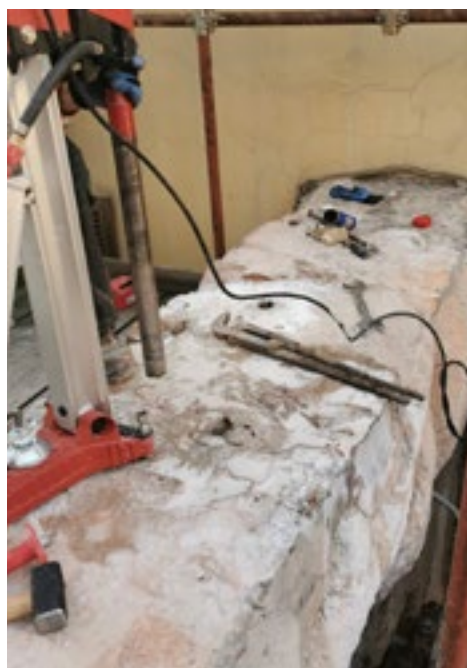
Rijeka, radovi na konstruktivnoj sanaciji Rimskog luka. Snimka: I. Jengiđ, 2024.
