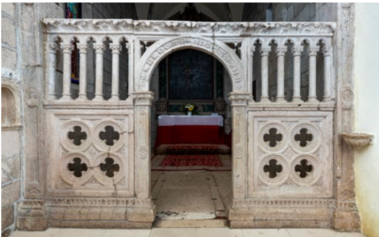
Hvar, franjevački samostan, crkva sv. Marije, kapela Sv. Križa, oltarna pregrada tijekom radova. Snimka: I. Sikavica, 2024.
