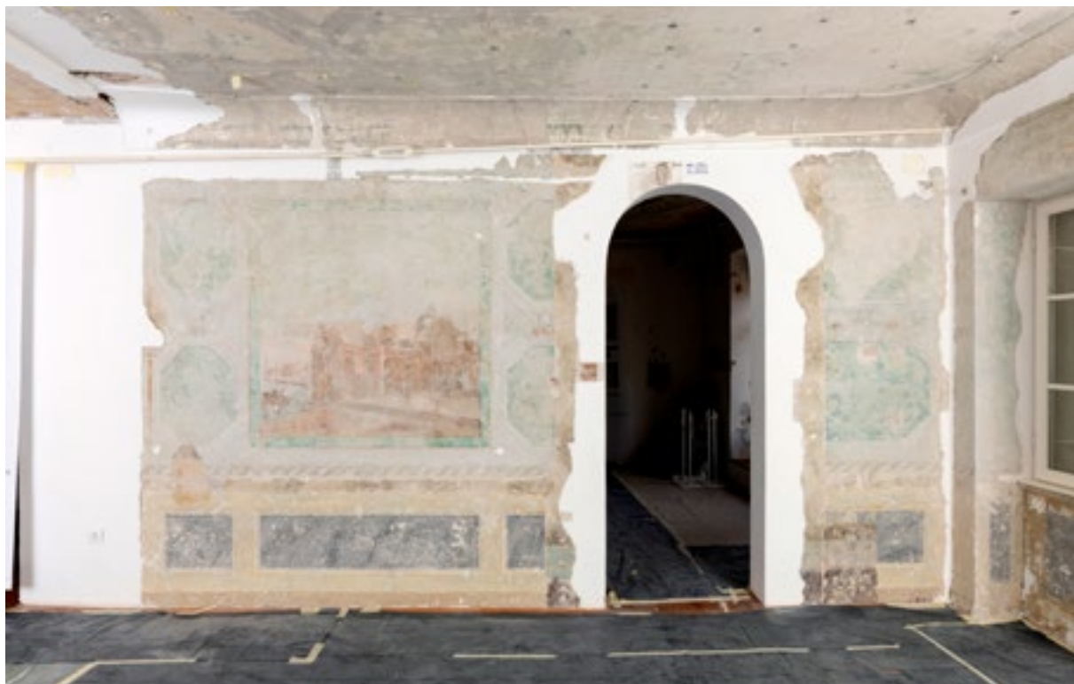
Rovinj, Muzej grada Rovinja (palača Califfi). Sjeverni zid zapadnog dijela prostorije 29b nakon uklanjanja recentnih slojeva naliča. Snimka: I. Marinković, 2024.
