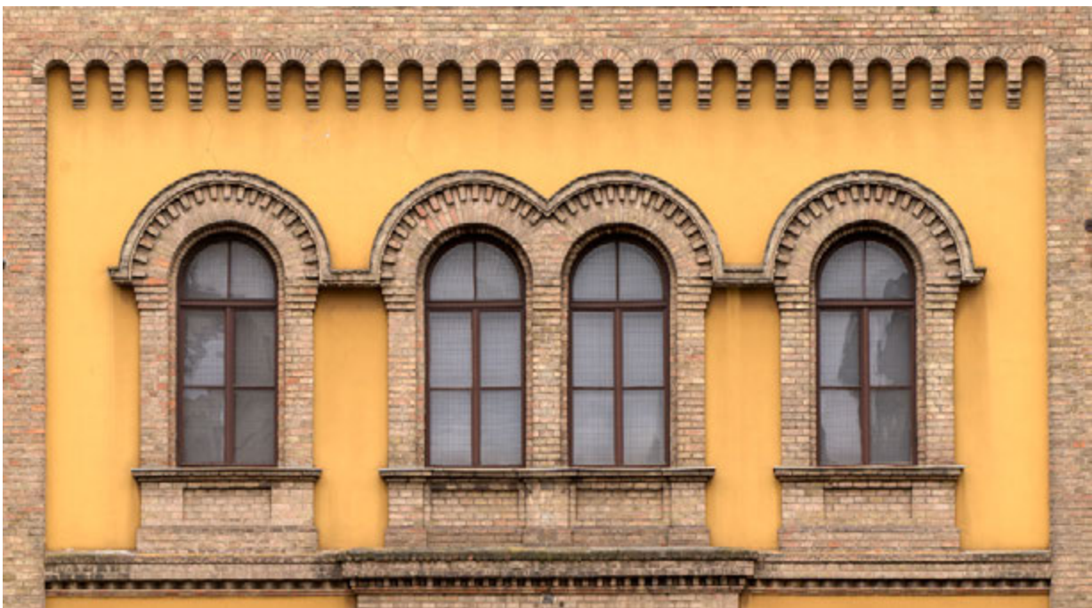
9. Prozorski otvori središnjeg rizalita sjevernog pročelja sjevernog krila (snimka: Lj. Gamulin, HRZ, 2021.) Windows on the central avant-corps on the northern façade of the northern wing (Lj. Gamulin, HRZ, 2021)
