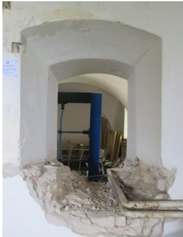
6. Dvorac Kerestinec, prozor koji pripada najstarijem građevnom sloju (snimka: V. Jakaša Borić, 2019.) Kerestinec castle, a window from the oldest building phase (V. Jakaša Borić, 2019)
