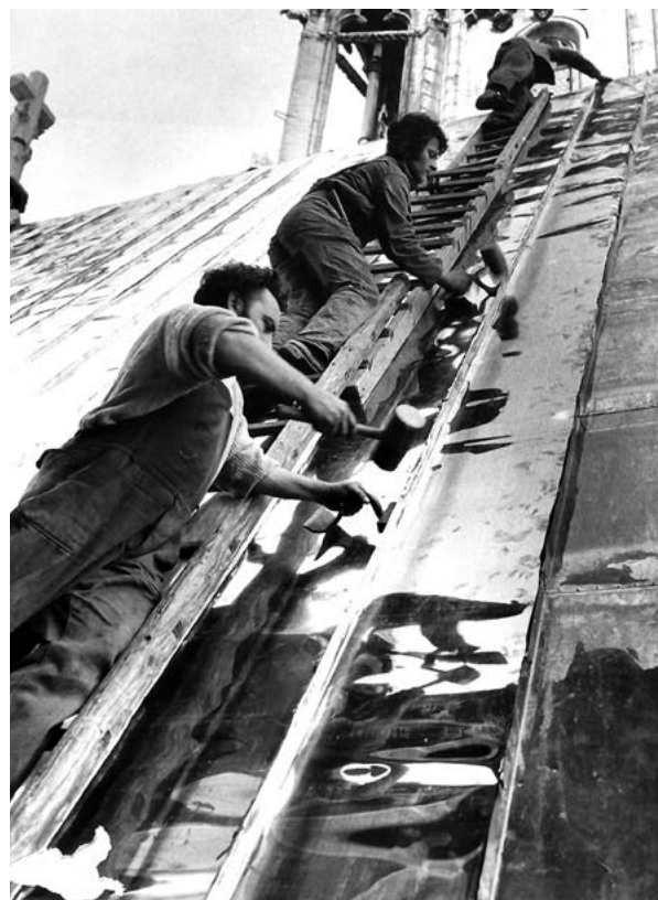
8. Pokrivanje krova zapadnog zabata između tornjeva bakrenim limom (MKM-KOZG, rujna 1976.) Copper-sheet roof covering on the west gable between the towers (MKM-KOZG, September 1976)
