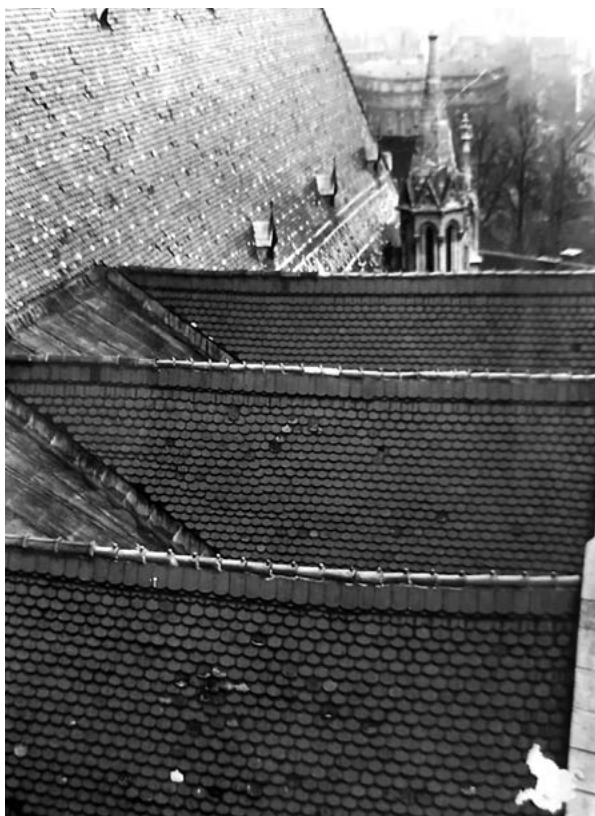
7. Južna strana krovišta glavnog broda i zabati bočnog broda (MKM-KOZG, 1976.) South side of the roof of the nave and the gable of the side nave (MKM-KOZG, 1976)
