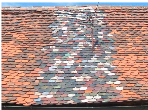
11. Glazirani crijev skinut s katedrale 1978. i iskorišten za popravak krova pomoćne zgrade, Kaptol 27 (Zagrebačka nadbiskupija, Ured za kulturna dobra, snimka: T. Plukavec, 2014.) Glazed tiles removed from the cathedral in 1978 and used to repair the roof of an auxiliary building, Kaptol 27 (Zagreb Archdiocese, Office for Cultural Heritage, T. Plukavec, 2014)
