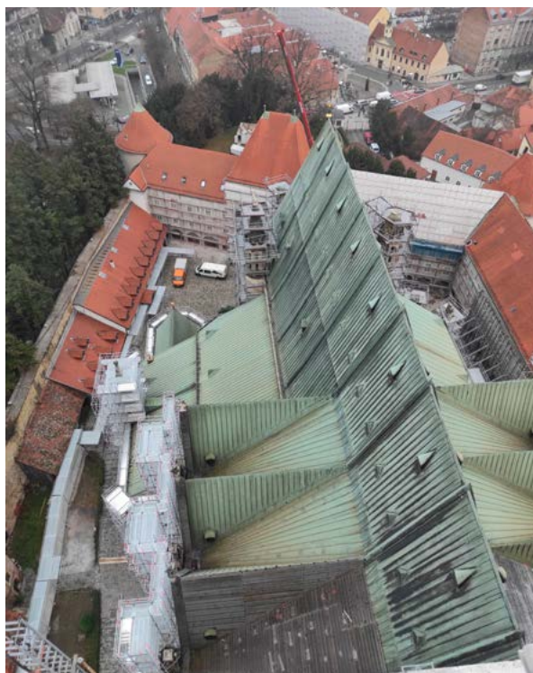
9. Bakreni pokrov, pogled sa sjevernog tornja prema svetištu (arhiva HRZ-a, snimka: K. Krulić, 2023.) Copper covering, view from the north tower towards the sanctuary (HRZ Archive, K. Krulić, 2023)
