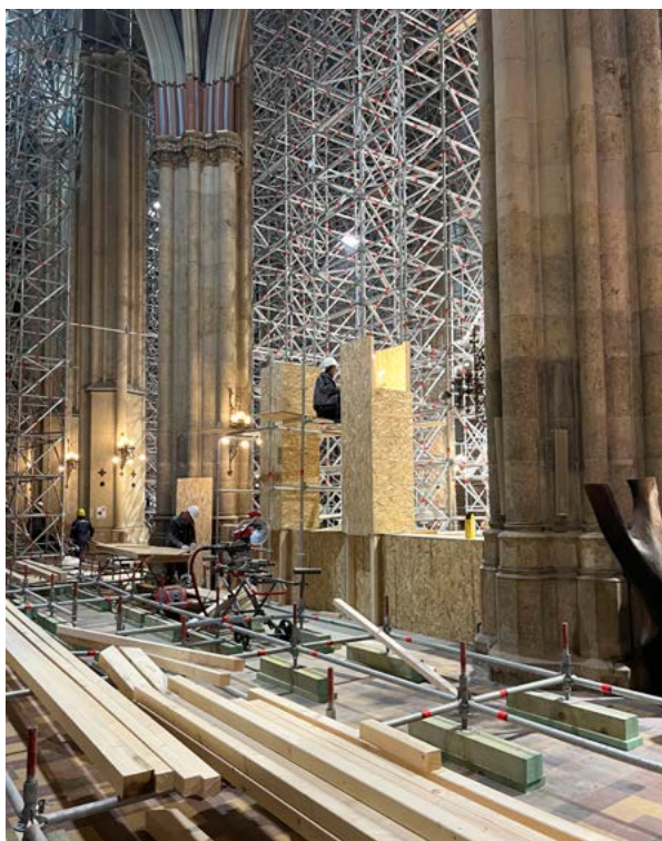
10. Sjeverni brod katedrale, izrada i postavljanje zaštitnih oplata nad dijelovima inventara (arhiva HRZ-a, snimka: K. Gavrilica, 2022.)
