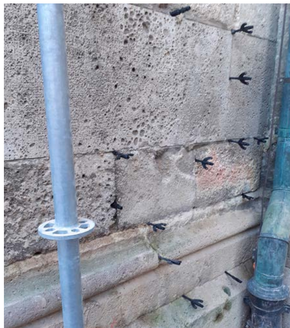
16. Primjer injektiranja kontrafora: pakeri za injektiranje malog promjera postavljeni u fuge i postojeće rupe u kamenu (fototeka GZZSKP-a, 2023.) Example of buttress injection: small-diameter injection packers placed in joints and existing holes in the stone (GZZSKP Photo Archive, 2023)
