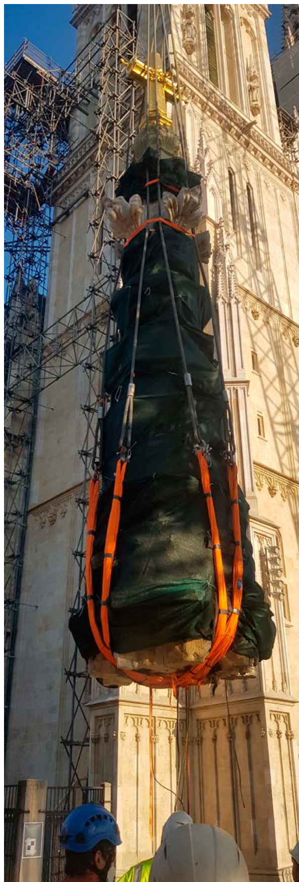
7. Spuštanje vrha sjevernog zvonika na tlo (fototeka GZZSKP-a, 2020.)
