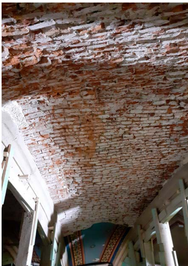
20. Pogled na izvorni svod nakon obijanja žbuke (fototeka GZZSKP-a, 2023.) View of the original vault after removal of plaster (GZZSKP Photo Archive, 2023)
