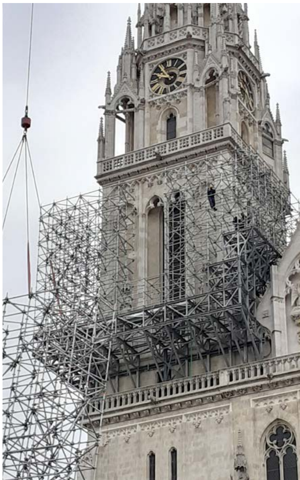
14. Postavljanje čelične skele na sjeverni zvonik (fototeka GZZSKP-a, 2023.) Installing steel scaffolding on the north bell tower (GZZSKP Photo Archive, 2023)
