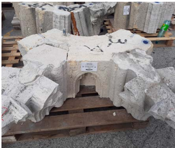
22. Demontirani kameni element sa sjevernog zvonika označen bar-kodom; sastavljen je od tri dijela: iz razdoblja izgradnje i iz dviju naknadnih obnova (fototeka GZZSKP-a, 2023.) Dismantled stone element from the north bell tower marked with a barcode. It is made up of three parts: from the construction period and two subsequent renovations (GZZSKP Photo Archive, 2023)
